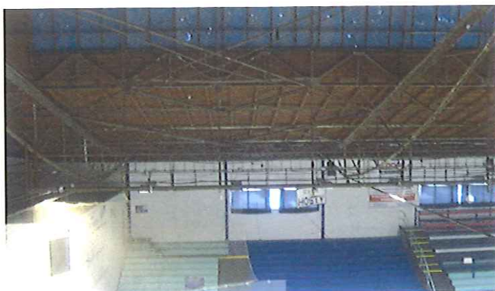
Foto příčného ztužidla a příhradového ztužení vrcholu vazníku.
