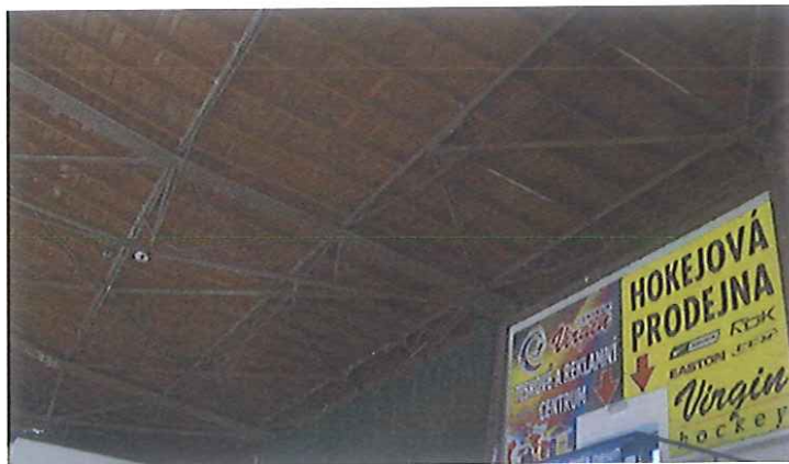
Foto podélného ztužidla, v levé části je část příčného ztužidla.
