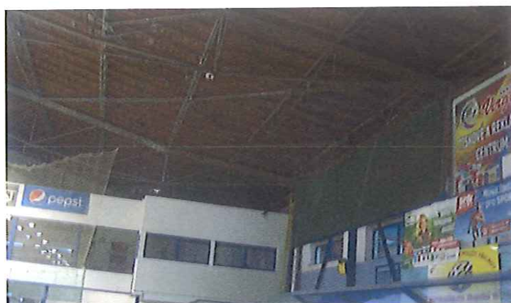
Foto příčného ztužidla v části s vaznicemi.
